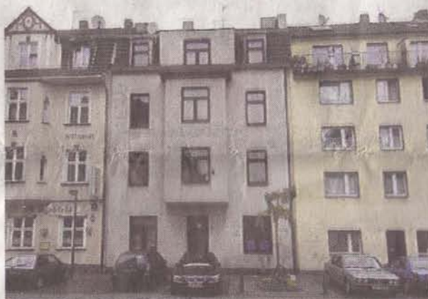
Das Wohnhaus Eigenstraße 48 (Mitte) in Hochfeld wird bis Oktober 2009 grundsaniert.
